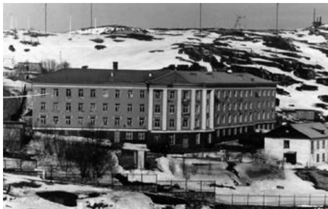
Рис. 6. Главный госпиталь Северного флота г. Полярное.
