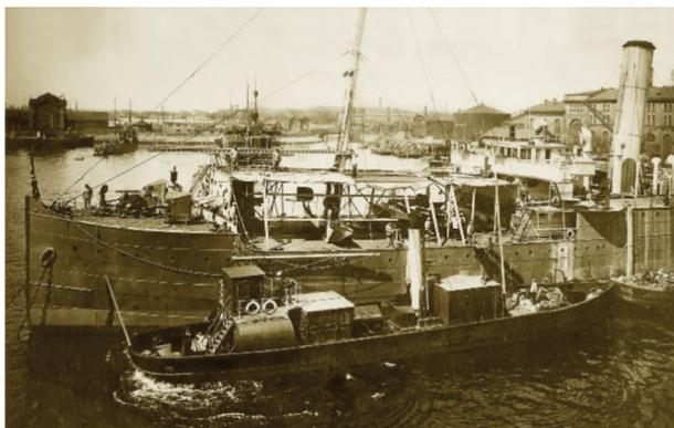
**Рис. 6.** Гидроавиатранспорт «Орлица» с летающими лодками Ф.В.А. Type С на борту
